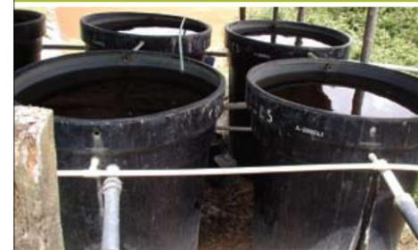
Figura 6 Reservorio para el almacenamiento de los lixiviados
