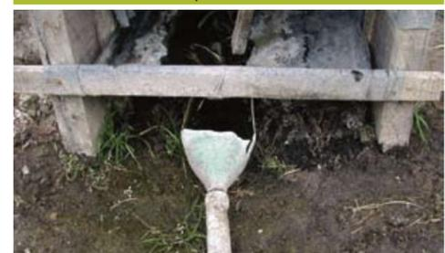
Figura 4 Tanque para la recolección y sedimentación de los lixiviados
